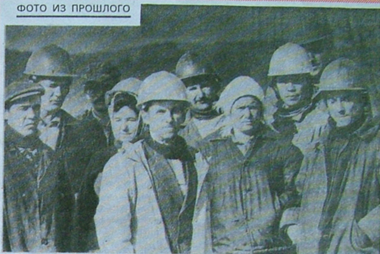
Строители СУ-7 треста «Уралавтострой», возводившие объекты МТУ
