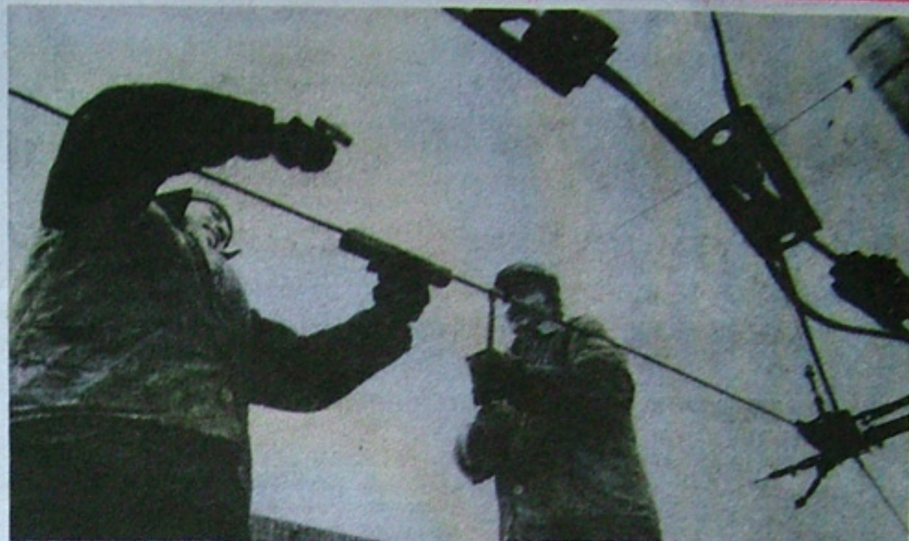
ЗА РАБОТОЙ — ЭЛЕКТРОМОНТЕРЫ ПО РЕМОНТУ КОНТАКТНОЙ СЕТИ
